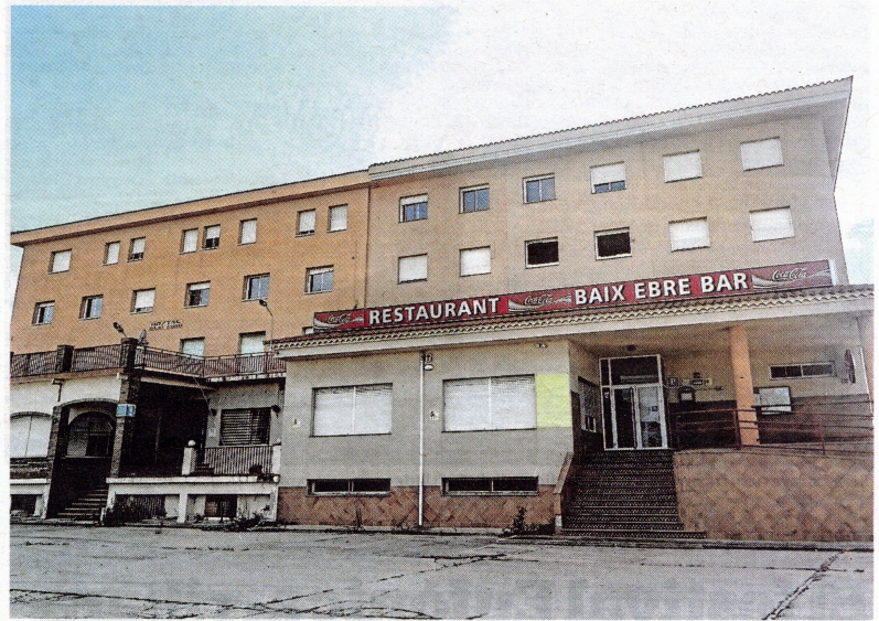
Estat actual de l'edifici de l'antic Hostal i Restaurant Baix Ebre a Amposta, a tocar de la carretera N-340. FOTO: JOAN REVILLAS
