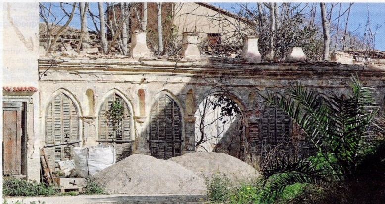
El pavelló de les arcades es rehabilitarà abans de construir l'Arxiu. FOTO: JOAN REVILLAS
