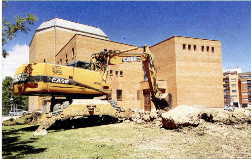
Una excavadora fa moviments de terra al solar que ocuparà l'ampliació del teatre auditori. //JOAN JOSEP CAROT
