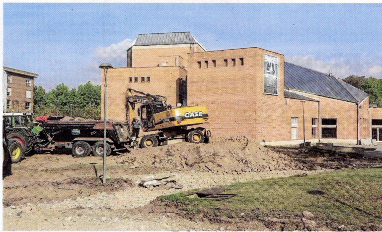
Treballs amb maquinària per a la construcció del nou edifici annex a l'actual. FOTO: JOAN REVILLAS
