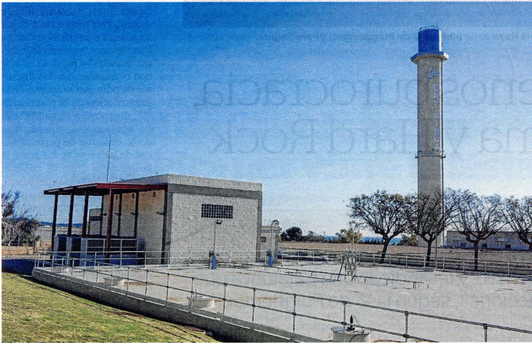
Instal·lacions de l'estació de tractament de l'aigua a l'Ampolla. FOTO: JOAN REVILLAS
