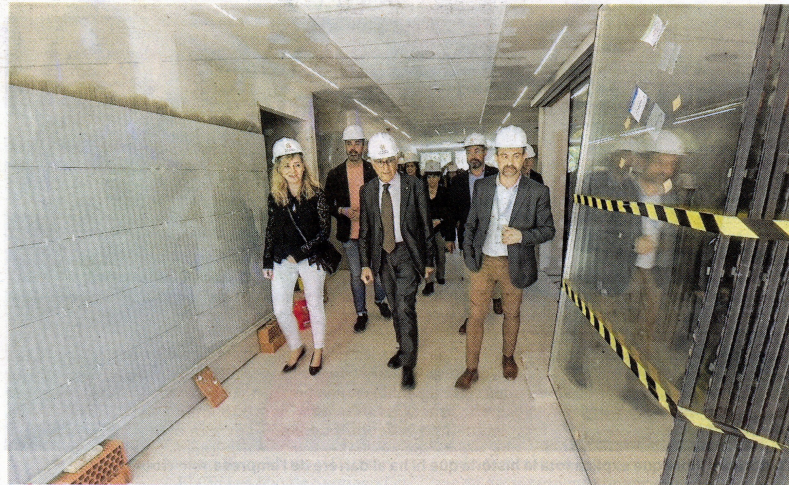
Visita a les obres d'ampliació del CAP Roquetes. FOTO: JOAN REVILLAS
