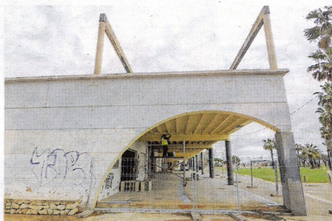
Obres a l'espai de sota, on als anys 2000 hi havia una zona d'oci nocturn amb pubs i locals de festa. FOTO: J. REVILLAS
