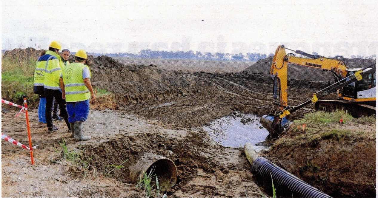
Màquines i operaris treballant en el pou del projecte. FOTO: ACN
