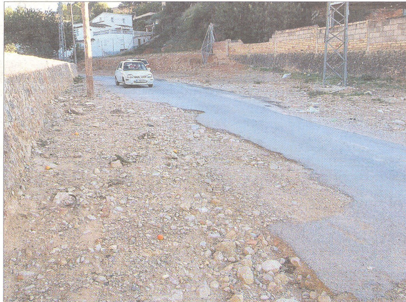
La canalització del barranc de la Llet al barri de Sant Llützer és una de les inversions per al 2013. FOTO: JOAN REVILLAS
