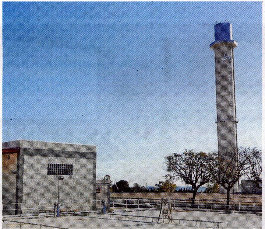
Instal·lacions del CAT a l'Ampolla. FOTO: JOAN REVILLAS
