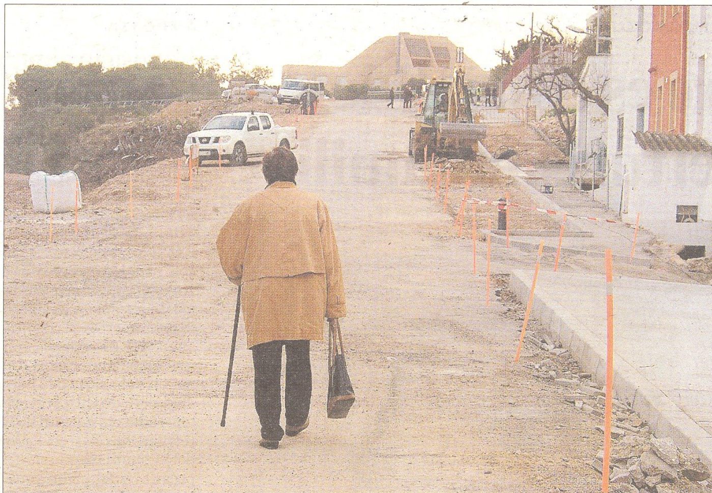
Aquest és l'estat actual de les obres al lligallo de Vinallop. FOTO: JOAN REVILLAS
