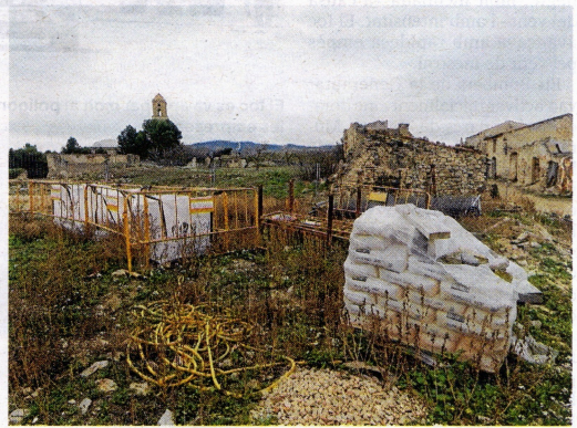
Obres parades al Poble Vell de Corbera d'Ebre. FOTO: JOAN REVILLAS
