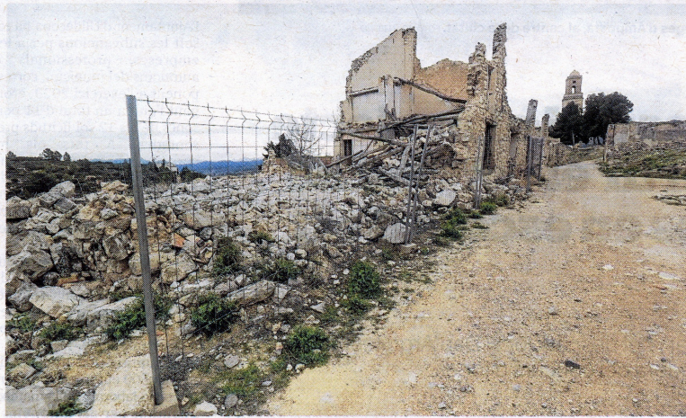
Tanques al Poble Vell, ahir al matí, on encara ha de finalitzar la primera fase de les obres. FOTO: J. REVILLAS
