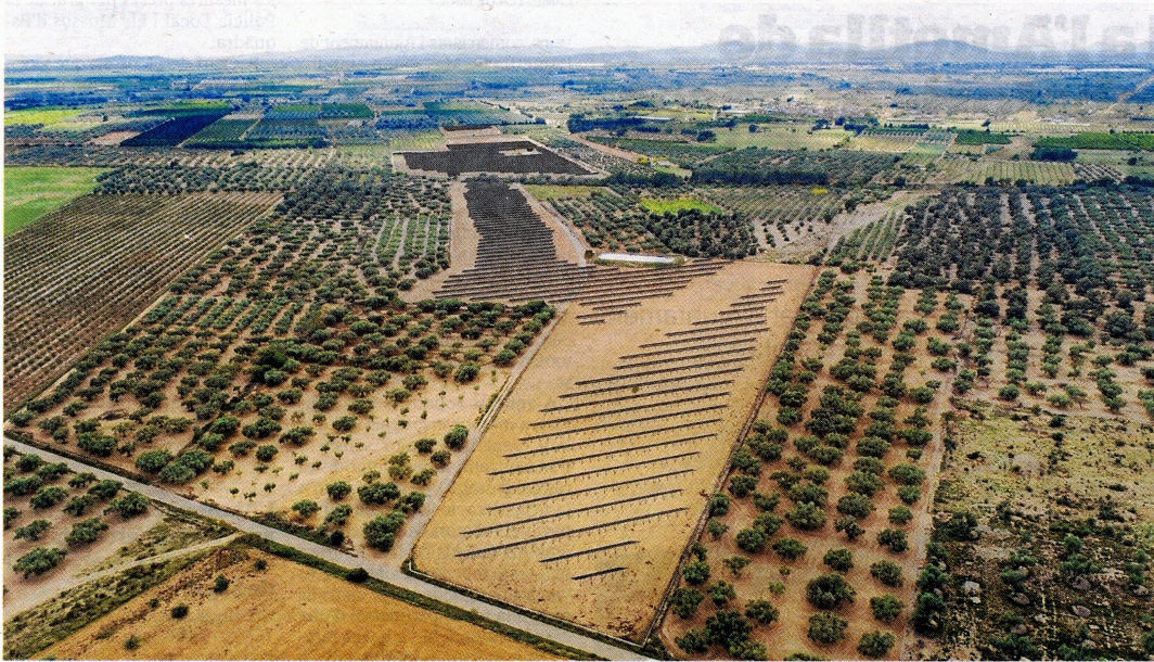
Render del projecte que es construirà vora els Valentins, que rebrà una ajuda de 44.500 euros. FOTO: DEPARTAMENT D'ACCIÓ CLIMÀTICA
