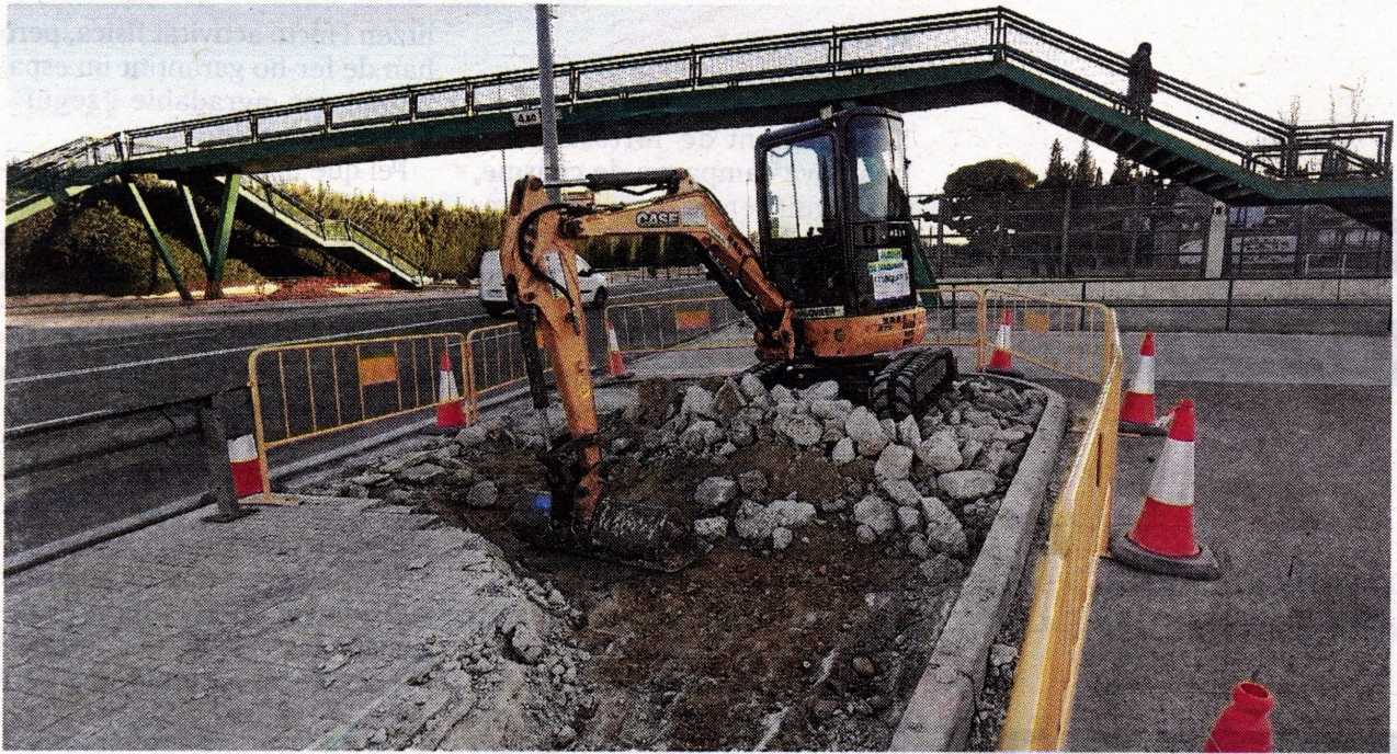
Obres per instal·lar els nous ascensors a la passarel·la, a la C-12 a Tortosa. FOTO: JOAN REVILLAS
