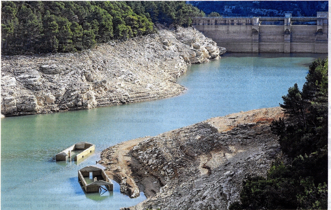
Estat actual de l'embassament, on el baix nivell de l'aigua ha fet emergir antigues construccions. FOTO: JOAN REVILLAS
