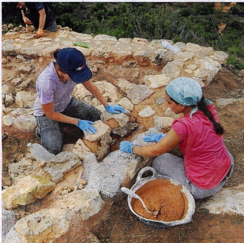
Els treballs han consistit en la reconstrucció de murs. FOTO: GRAP
