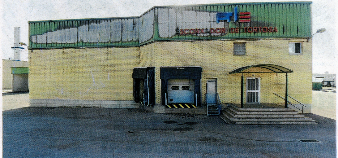
L'escorxador municipal, tancat ahir després de l'incendi. FOTO: JOAN REVILLAS
