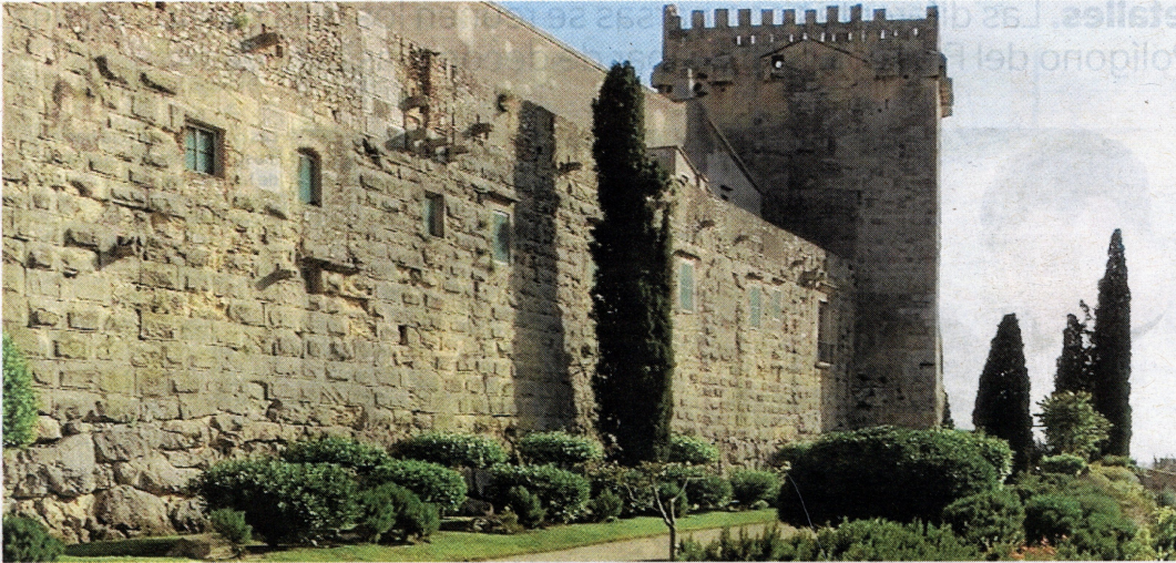
Torre de l'Arquebisbe de l'antic Palau del Paborde, a Tarragona, on el papa Adrià VI s'hostatjà durant un mes en la seva visita a la ciutat.
