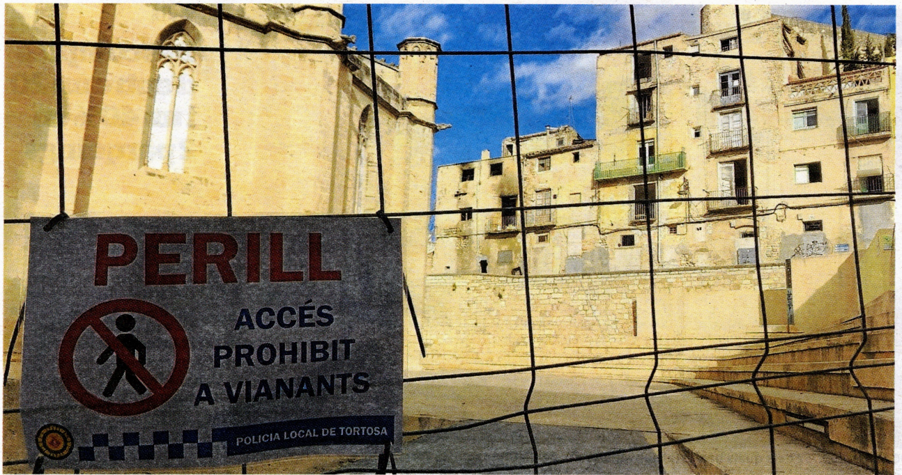
Cartell que avisa de la prohibició d'accedir a la plaça, amb l'immoble incendiat al fons. FOTO: M. MILLAN
