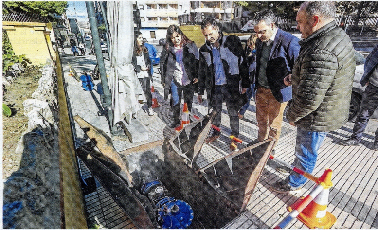
S'instal·larà una turbina a l'avinguda Generalitat a l'altura del parc Teodor González. FOTO: J. REVILLAS
