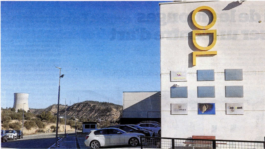
El polígon industrial d'Ascó amb la torre de refrigeració de la central nuclear a l'esquerra, al fons. FOTO: JOAN REVILLAS
