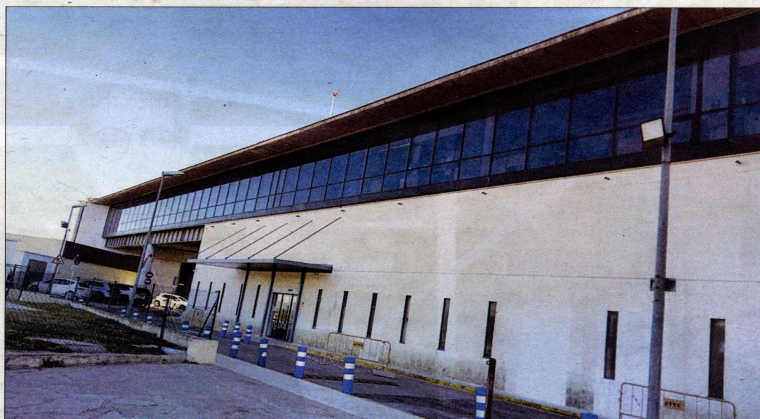
Després d'algunes ubicacions provisionals, l'Escola d'Infermeria va quedar instal·lada a l'annex de l'hospital construït el 1984.
