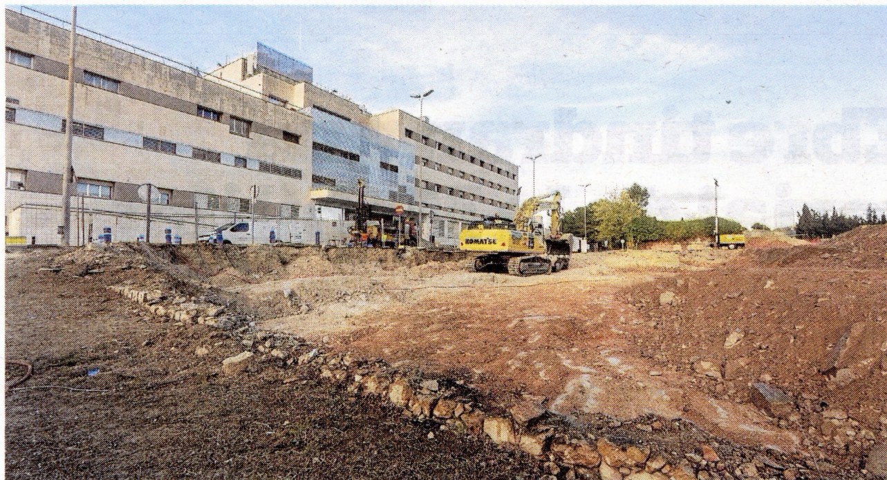
Estat de les obres davant de l'Hospital Verge de la Cinta, aquesta setmana. FOTO: JOAN REVILLAS
