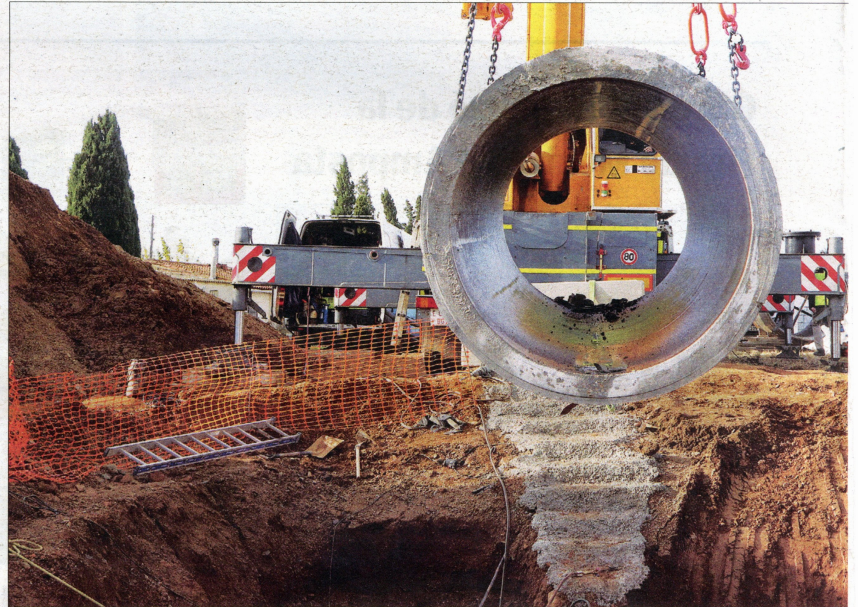
Obres recents per canviar un tram de la canonada principal del CAT, la xarxa del qual podria abastir vaixells amb aigua amb destí
