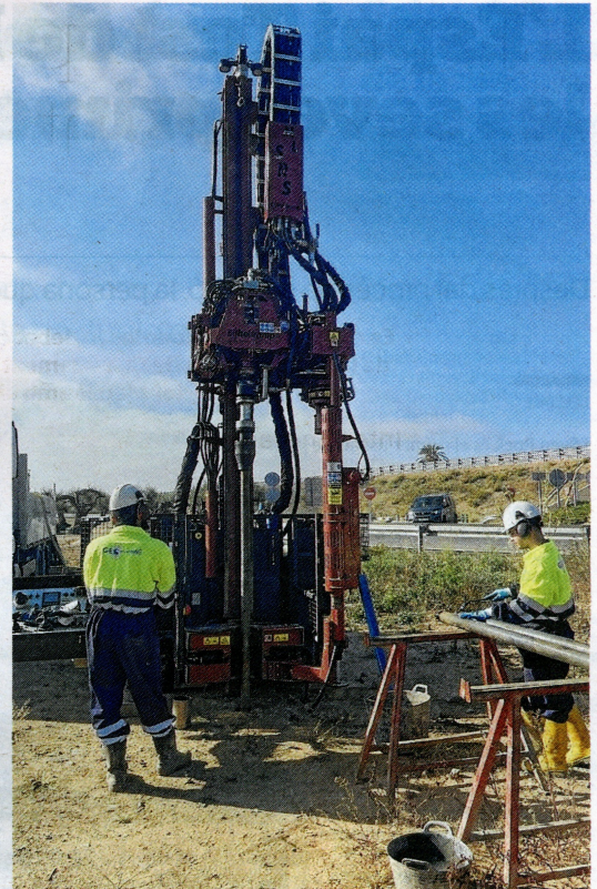
Operaris de l'empresa contractada extraent terra submarina amb una maquinària especial prop del litoral d'Alcanar. FOTO: GRAP
