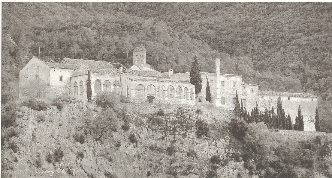
Imatge de l'estat del complex d'edificis de l'antic balneari de Cardó, alguns dels quals estan en ruïna, aquesta setmana. FOTO: JOAN REVILLAS
