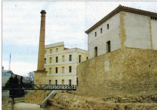
Una de les actuacions que es posarà en marxa és la rehabilitació de les Cases del Castell.
