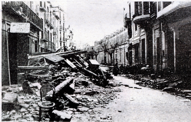
Destrosses acumulades a l'actual avinguda de la Generalitat. Al fons, el mercat. FOTO: CEDIDA
