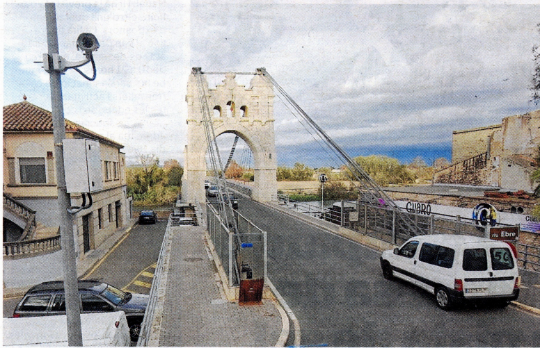
Una de les càmeres de videovigilància ja instal·lades a Amposta. FOTO: JOAN REVILLAS
