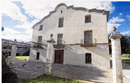
El Barnahus estarà ubicat en una masia rehabilitada al barri de Ferreries, a la urbanització vora Quatre Camins. FOTO: J. REVILLAS
