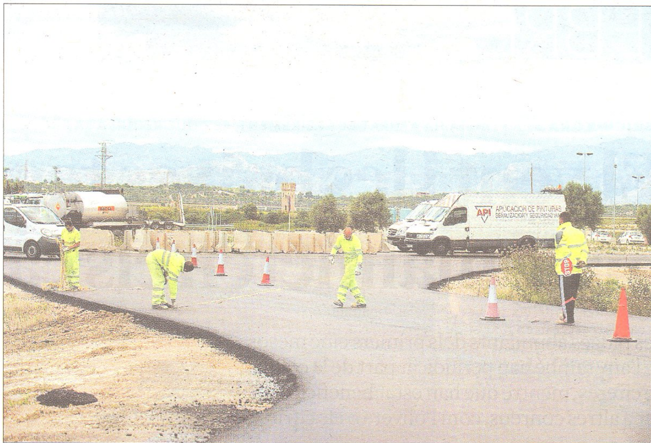
Obres a la connexió sud de la variant, ahir al migdia. FOTO: JOAN REVILLAS
