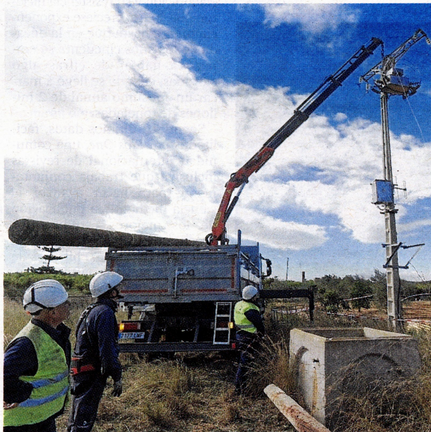
Treballs per desmuntar la línia provisional, ahir. FOTO: JOAN REVILLAS
