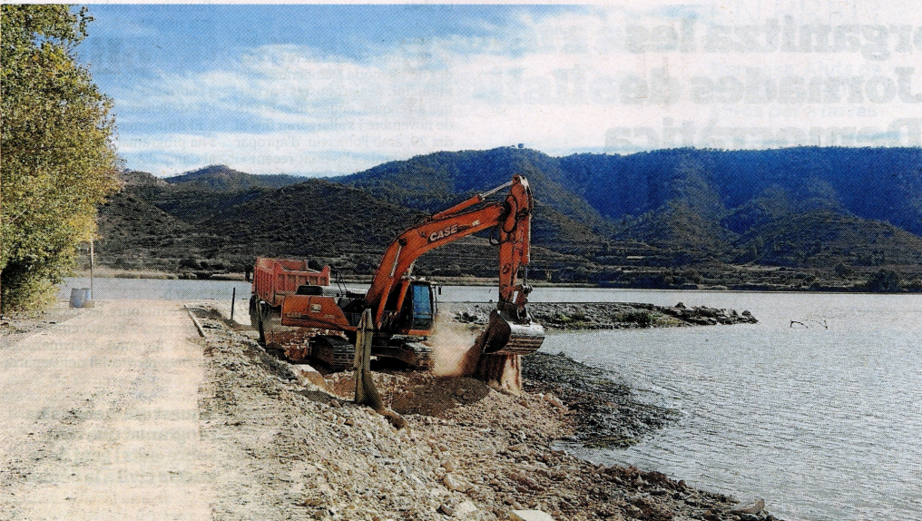
Treballs per condicionar l'àrea per poder iniciar la mobilització de sediments, ahir a Mequinensa. FOTO: ACN
