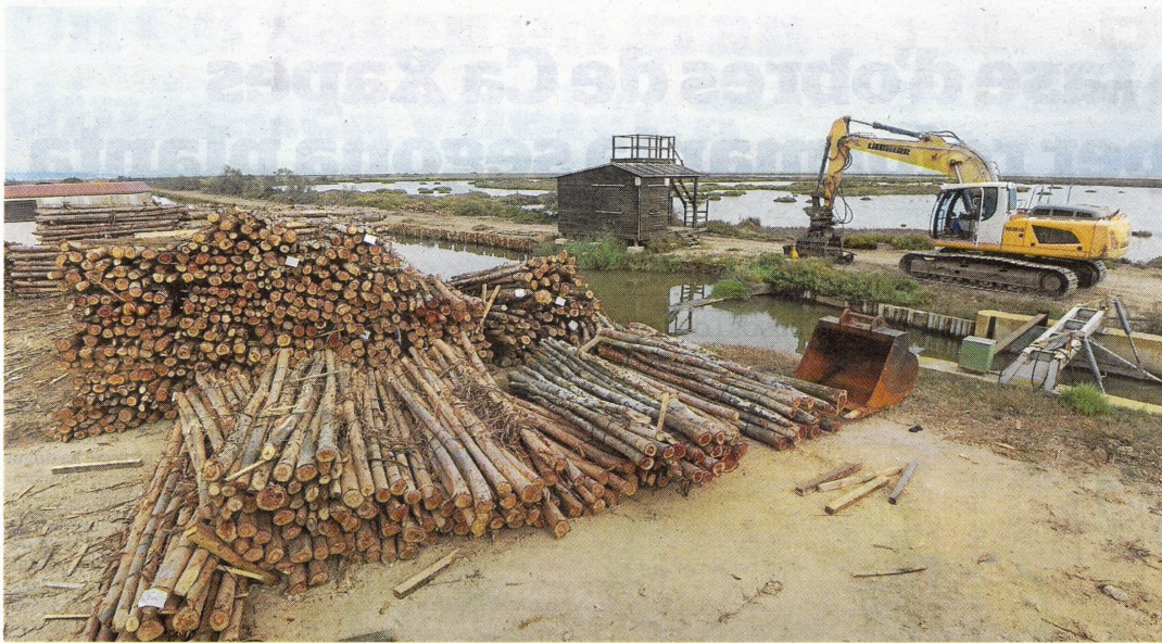
Maquinària treballant amb un total de 6.000 pals de fusta per reforçar la llacuna, a l'illa de Buda. FOTO:JOAN REVILLAS
