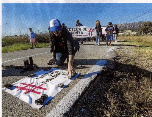
La falta de vorals i la poca fiabilitat de les línies pintades són alguns dels problemes que presenta la via. FOTO: JOAN REVILLAS
