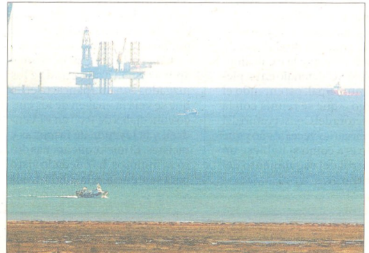
La planta marina de gas, situada davant les costes de Vinaròs i Alcanar. FOTO: JOAN REVILLAS
