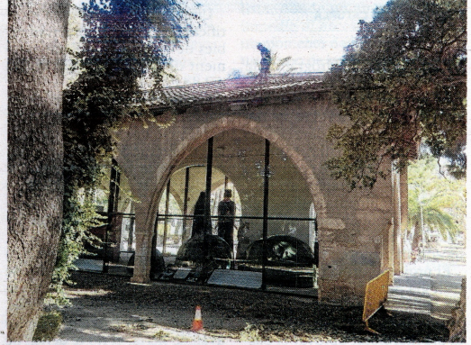
Operaris treballant a la teulada de l'edifici històric. FOTO: J. REVILLAS
