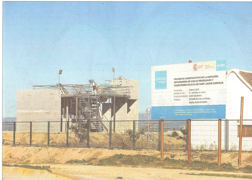
La planta depuradora de Sant Jaume d'Enveja, ubicada al delta de l'Ebre, no s'ha posat en marxa. FOTO: J. REVILLAS
