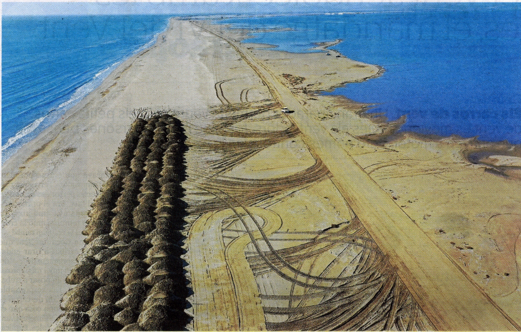
Imatge aèria de la barra del Trabucador, després dels treballs d'aportació d'arenas. FOTO: CEDIDA
