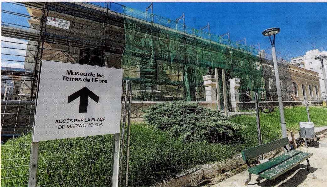
Mentre duren les obres de rehabilitació l'accés al Museu és per la plaça Mari Chordà. FOTO: JOAN REVILLAS
