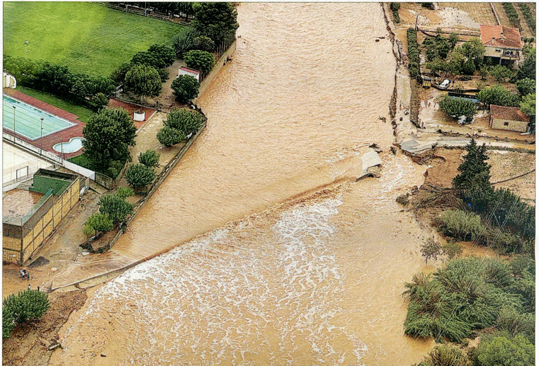
Imatge del barranc de la Galera al seu pas per Masdenverge, just pel costat del complex esportiu municipal / BOMBERS DE LA GENERALITAT
