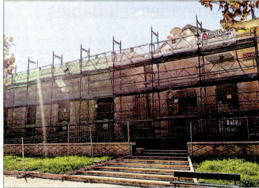
Obres de remodelació del Museu Terres de l'Ebre. / VÍCTOR MONTECINO VALLS
