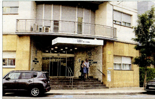
Imatge de l'accés a la Clínica Terres de l'Ebre
