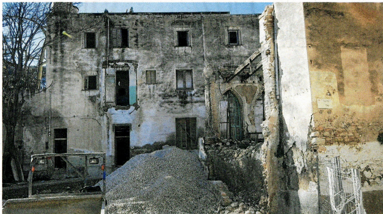
Espai de la zona del balneari del Porcar on van començar les obres. FOTO: JOAN REVILLAS
