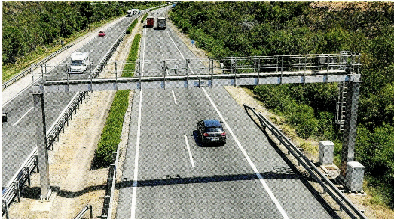
L'autopista AP-7 al seu pas per Amposta. FOTO: JOAN REVILLAS
