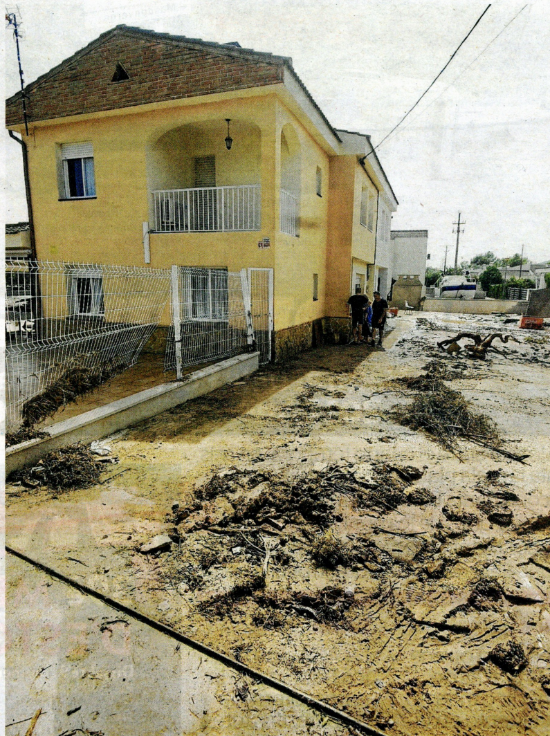
Destrozos y barro en Alcanar Platja, una de las zonas más afectadas por el temporal. FOTO: JOAN REVILLAS
