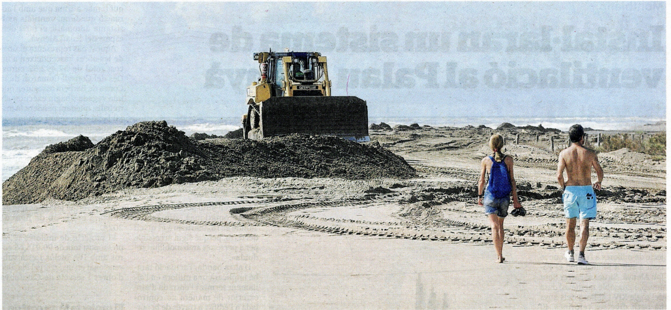
Les màquines treballant per dipositar arena al Trabucador, aquest dimecres. FOTO: JOAN REVILLAS
