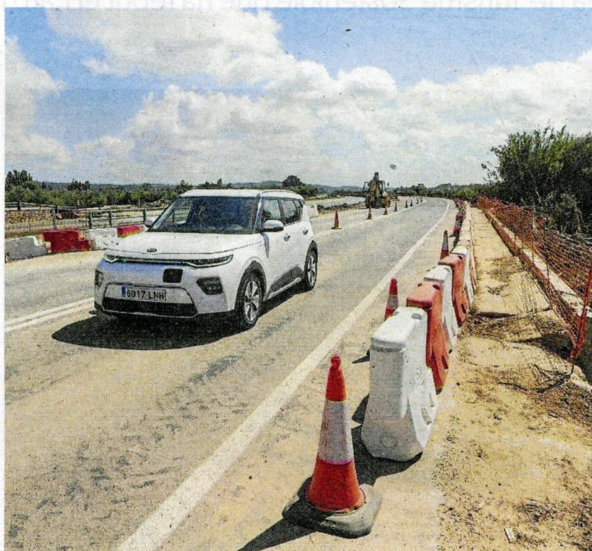
Estat actual dels treballs per posar a punt la carretera C-12.
