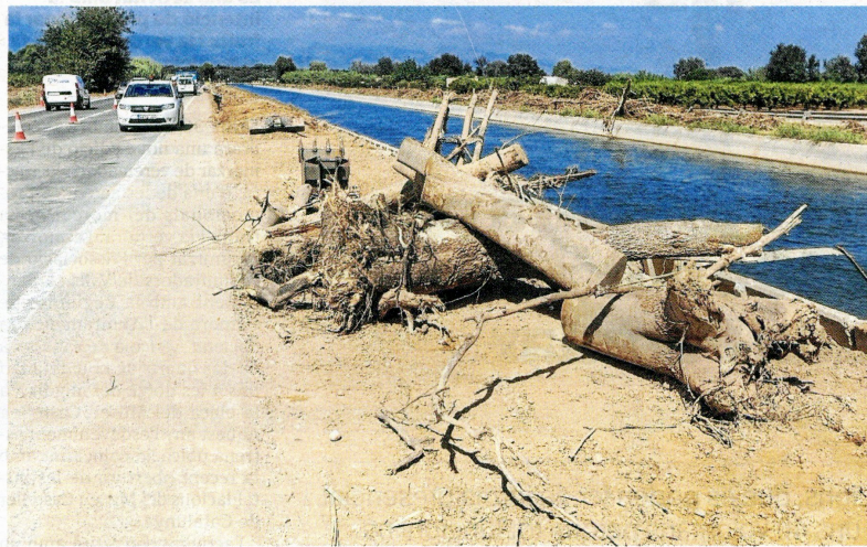
Danys del barranc de la Galera a la carretera C-12, entre Amposta i Tortosa. FOTO: JOAN REVILLAS
